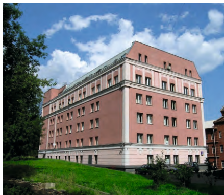
Офисный центр г. Москва Мультизональные системы Dantex
