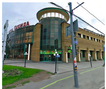
Торгово-развлекательный центр г. Москва Мультизональные системы Dantex
