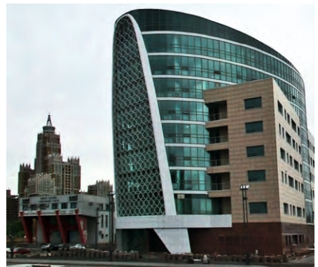
Гостиничный комплекс Казахстан, г. Астана Мультизональные системы Dantex
