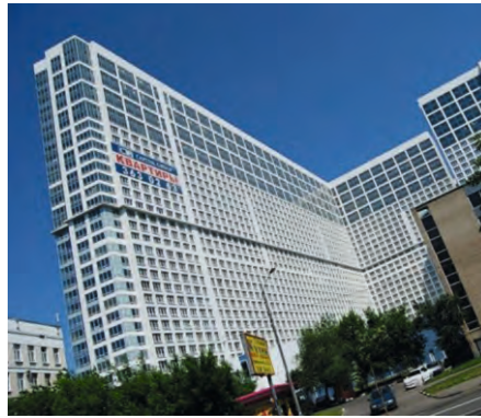
Жилой комплекс "Аэробус" г. Москва Мультизональные системы Dantex
