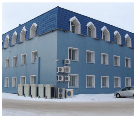
Офисный центр г. Сыктывкар Мультизональные системы Dantex
