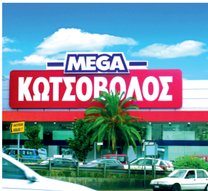
KOTSOVOLOS Торговый центр Греция
