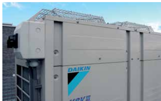
Система VRV с рекуперацией тепла
