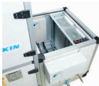
Установленный и испытанный на заводе фреоновый теплообменник
