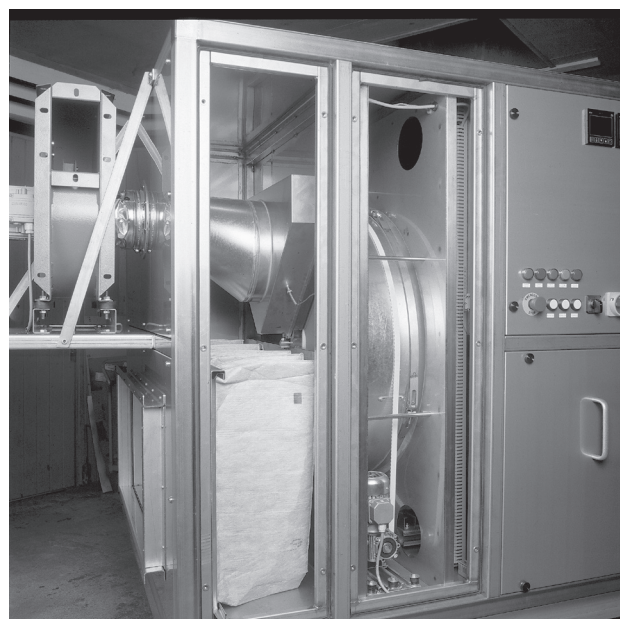
Ротор с силикагелем
