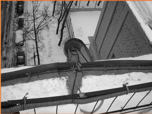
Предмонтажная проверка нагревательного кабеля
