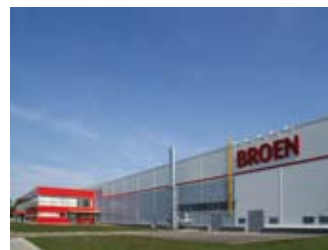
Производственный комплекс BROEN в Коломне
