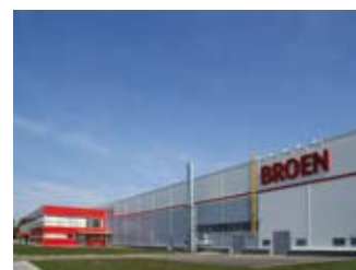
Производственный комплекс BROEN в Коломне
