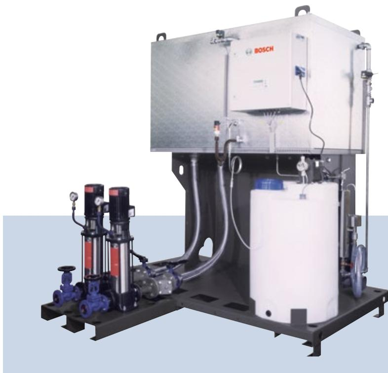
Модуль водоснабжения WSM-T для частичной деаэрации подходит для всех паровых котлов с производительностью до 8 000 кг/час
