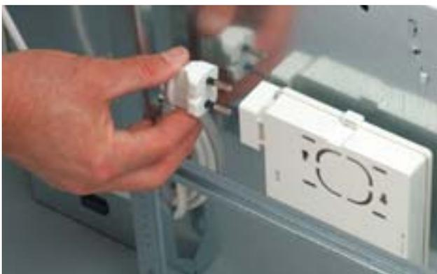
Существуют два варианта монтажа конвекторов серий P и L, не требующие дополнительного оборудования: с помощью штепсельной вилки для стандартных электрических розеток и с помощью распределительной коробки для стационарного соединения с источником питания.
