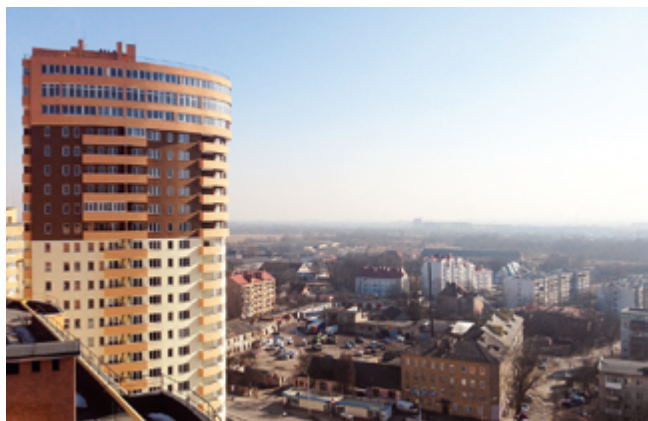
ЖК «Вальдау», г. Калининград Общая мощность котельной — 4 МВт
