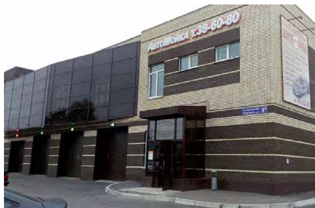
Автосервис, г. Йошкар-Ола Общая мощность котельной — 500 кВт
