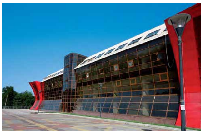
Спорткомплекс «Гладиатор», г. Нальчик Общая мощность котельной — 1,2 МВт
