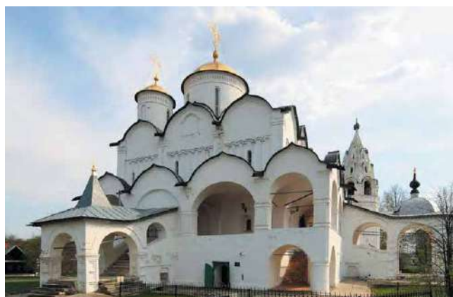
Покровский собор, г. Суздаль Общая мощность котельной — 65 кВт
