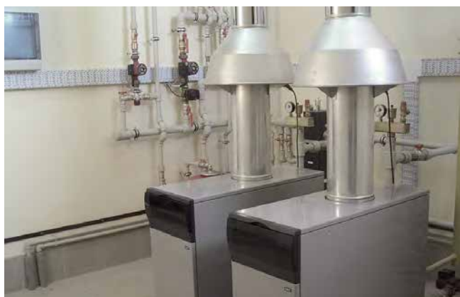
Складской комплекс, г. Нижний Новгород Общая мощность котельной — 100 кВт
