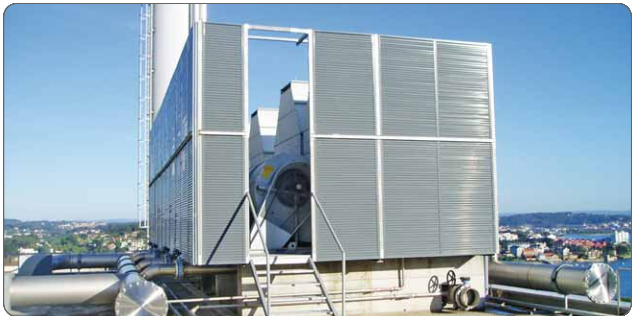
Рисунок 10. Архитектурные стены, возведенные вокруг градирен с закрытым контуром
