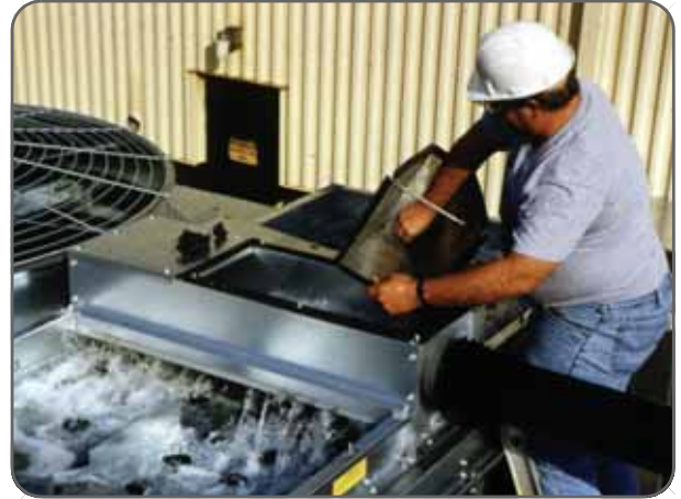
Очистка сетчатого фильтра бассейна горячей воды
