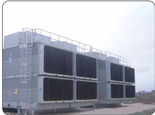
Рисунок 11. Градирня ВАС серии 3000, снабженная шумоглушителями на впуске и выбросе воздуха
