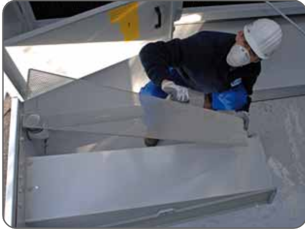
Осмотр сетчатого фильтра бассейна холодной воды
