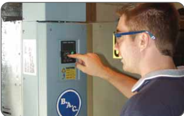
Рисунок 8. ЧРП со встроенным шунтом
