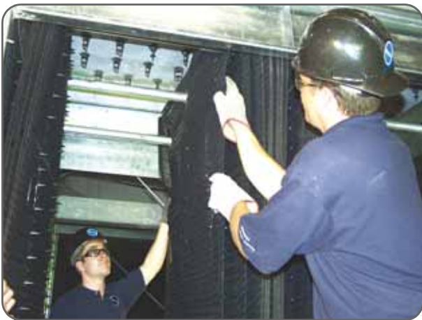
Установка комплекта модернизации
