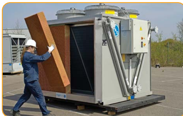
Установка предохлаждающего материала
