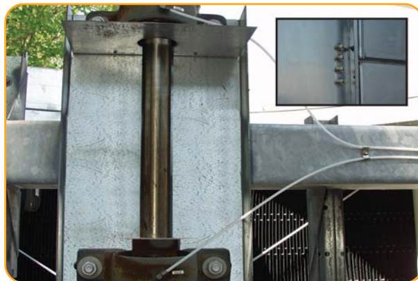
Удлиненные смазочные линии
