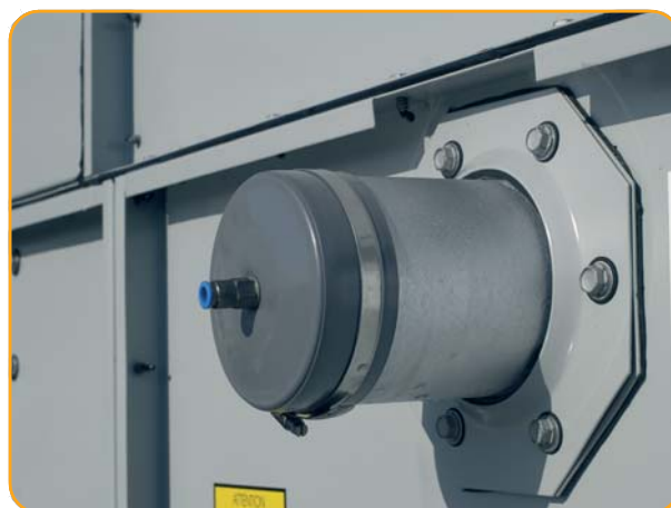
Заполнение змеевика азотом
