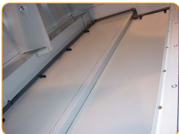
Трубы очистителя бассейна
