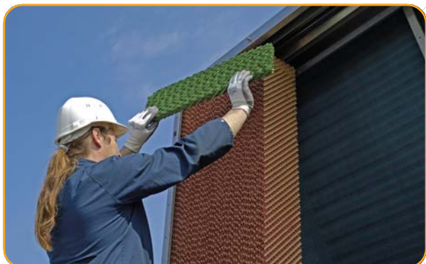
Монтаж водораспределительной панели
