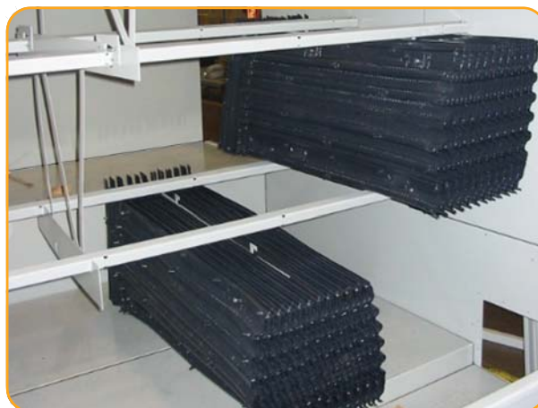
Легко снимаемые пакеты наполнителя
