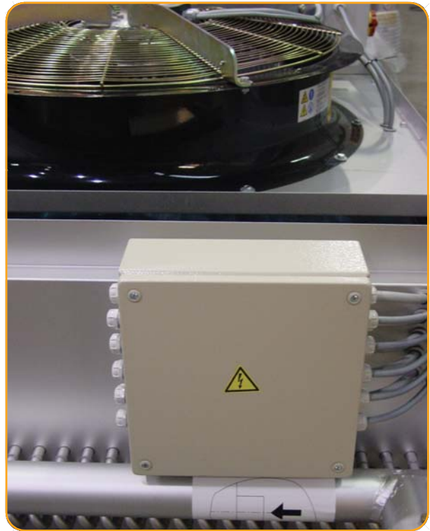
Подключение к распределительной коробке
