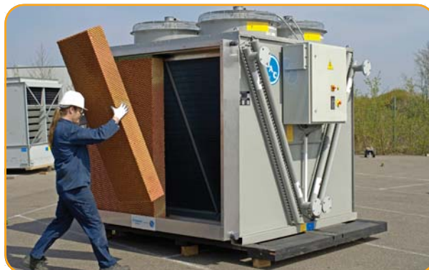
Установка предохлаждающего материала
