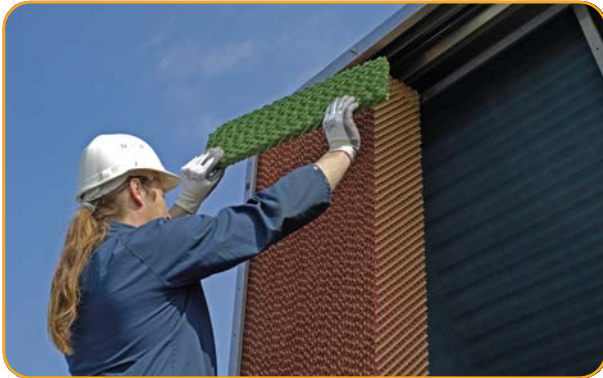
Монтаж водораспределительной панели
