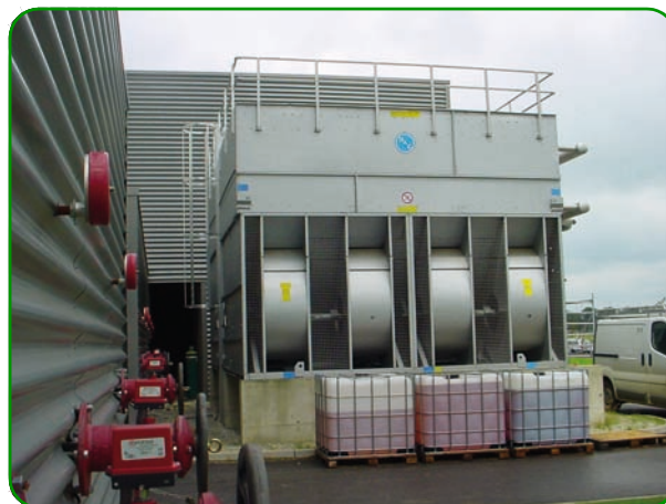
Лестница и защитное ограждение
