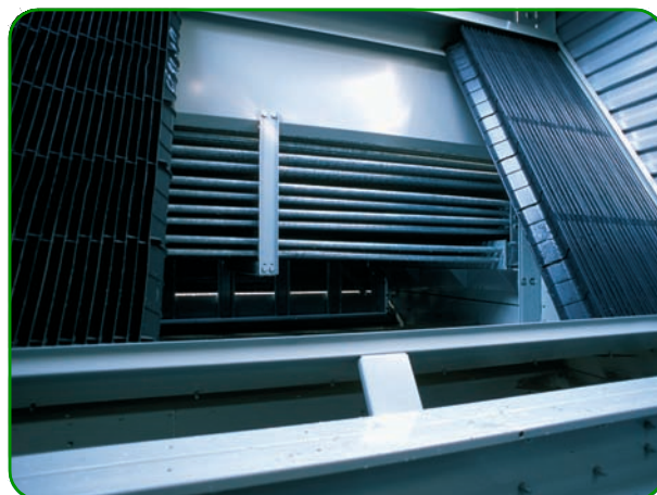
Легкий доступ к секции теплообменника
