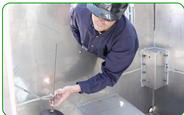
Регулятор уровня воды легко доступен через дверцу люка.
