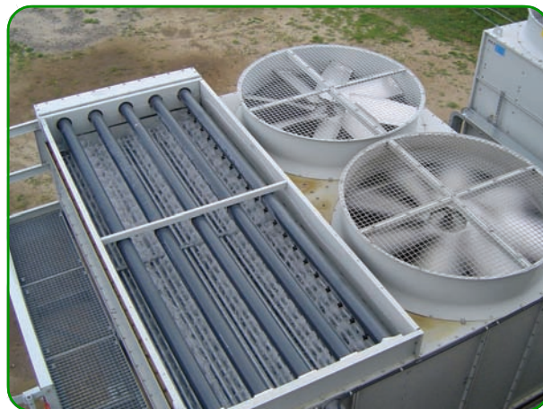
Система раздачи воды для орошения
