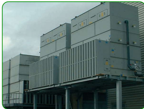
Изделие с шумоподавлением на впуске и выпуске
