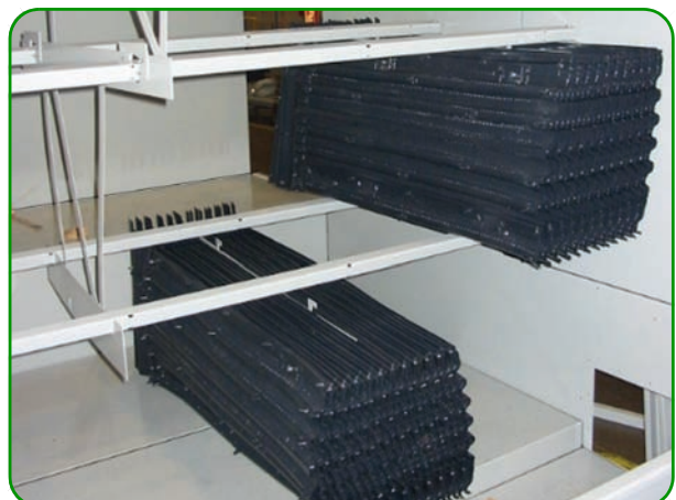
Легко снимаемые пакеты наполнителя
