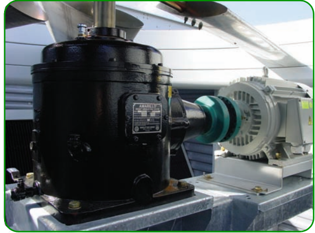
Система зубчатой передачи, сопряженный электромотор
