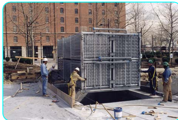
Монтаж модуля змеевика
