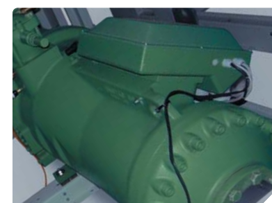
Полугерметичный винтовой компрессор
