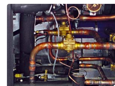
Два холодильных контура
