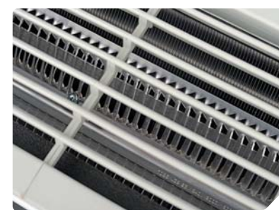
Встраиваемый электронагреватель для дополнительного нагрева.
