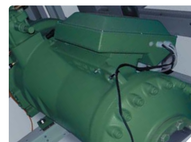
Полугерметичный винтовой компрессор
