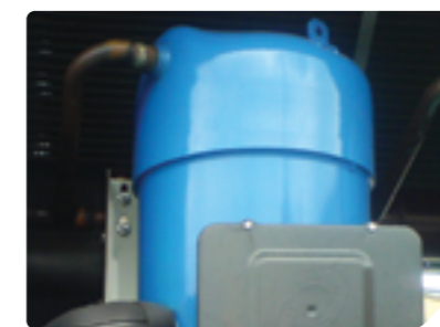
Высокоэффективный спиральный компрессор
