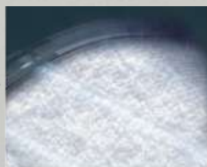
Обмерзание теплообменника
