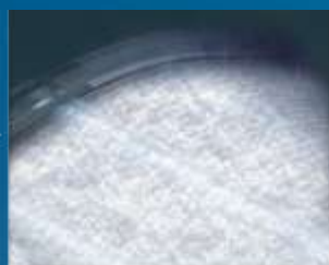
Обмерзание теплообменника
