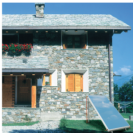
Пример наземного монтажа
