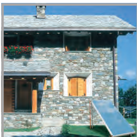
Пример наземного монтажа
