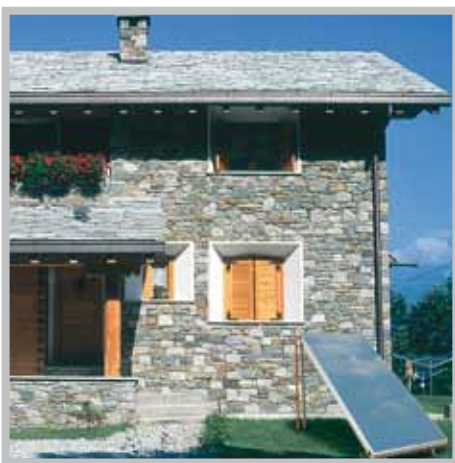
Пример наземного монтажа
