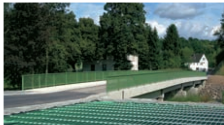
Отопление открытых площадей
