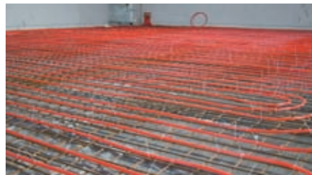
Система тёплого пола в промышленном помещении
