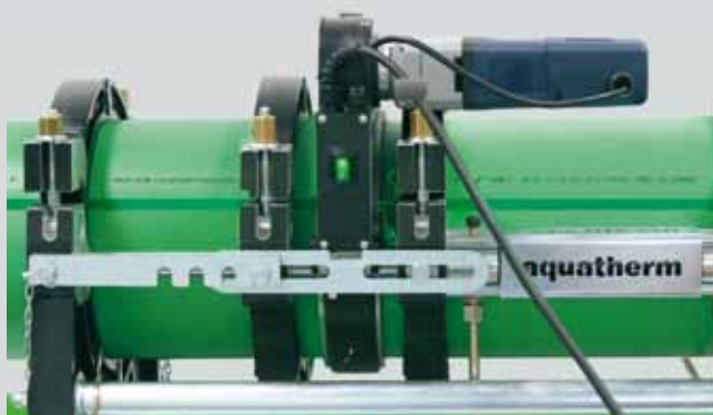
Свариваемые части вставить, выровнять и зафиксировать
