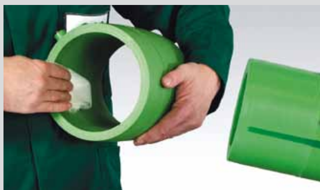
Очистка внутренней поверхности электромуфты неволокнистой салфеткой или тканью. Непосредственно перед сваркой проконтролировать нет ли вновь образовавшейся влаги и удалить её.
