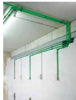
Монтаж на штукатурку
