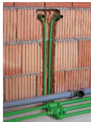
Монтаж под штукатурку
