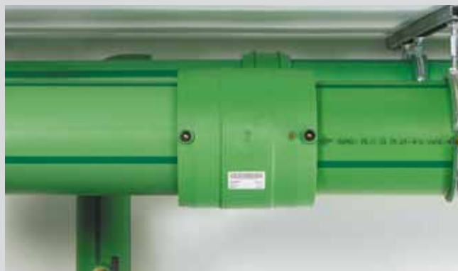
Насаживание второй, тоже очищенной и зачищенной трубы в муфту
