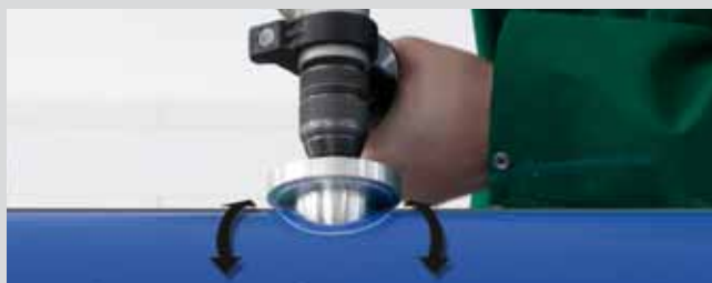
Снятие кислородонепроницаемого слоя с трубы aquatherm blue pipe OT
