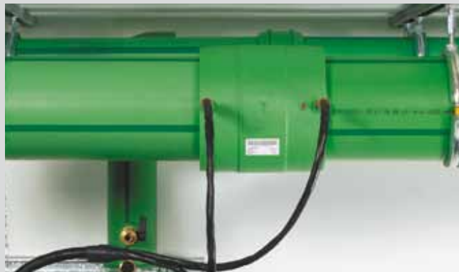
Сварочный аппарат настроить на диаметр муфты. Начать процесс сварки. Выдержать время охлаждения. Готово!
