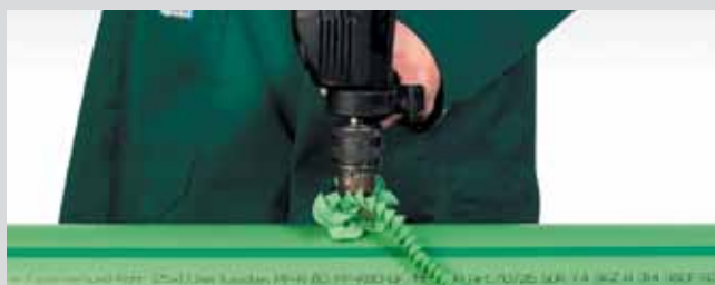
Просверливание отверстия в стенке трубы
