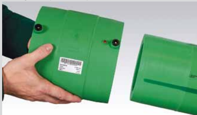
Насаживание электромуфты на зачищенный край трубы
