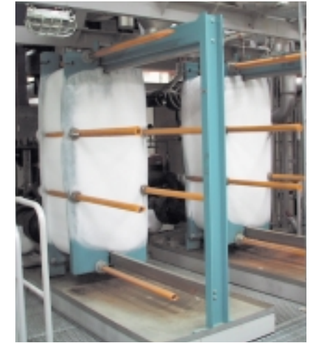
Рис. 5. Благодаря гибкой конструкции, теплообменник не разрушается при замерзании.
