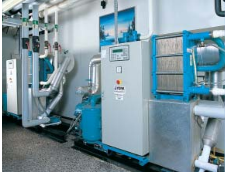
В машинном зале охлаждающей системы установлено два холодильных агрегата York Sabroe (хладагент – аммиак) с двойными компрессорами. В состав каждого агрегата входит никелевая пластинчатый теплообменник Альфа Лаваль NB76-FS.
