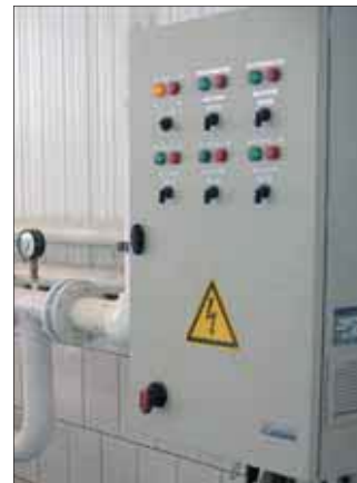
Ростов-на-Дону Шаф управления «Грантор» на пять насосов АЭП40-013-54Ч-55А 5,5 кВт
