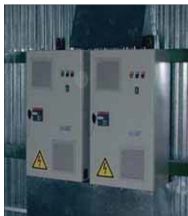
Клин Шаф управления «Грантор» со встроенными МП АЭП40-190-54П-11А 90 кВт
