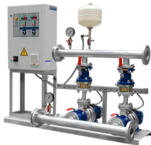
Частотное регулирование для каждого насоса
