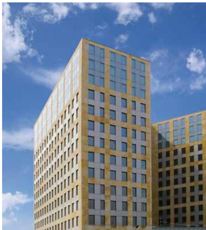
Офисное здание IO - 1 Варшава, Польша
