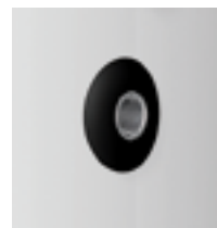
Гнездо установки температурного датчика котла
